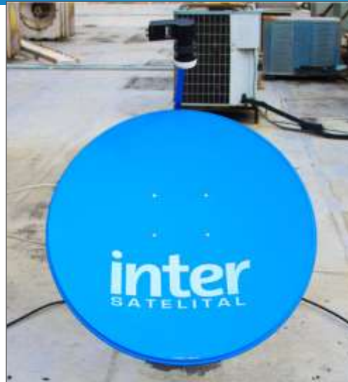
Imagen 26. Ensamble de la antena el brazo sostenedor de LNB en la parte superior del reflector.
