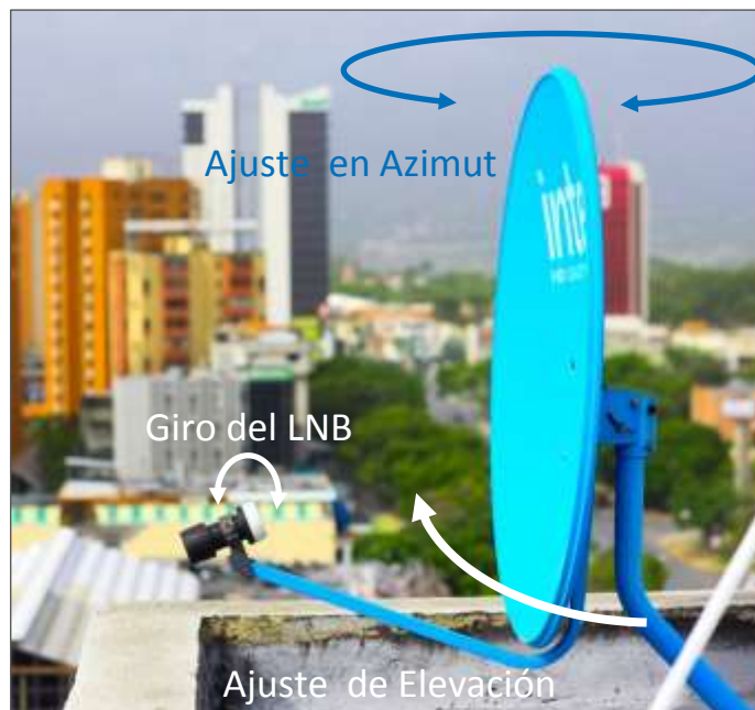
Imagen 20. Orientación de Antena.
